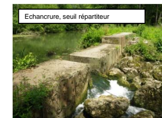
Amélioration du franchissement piscicole des ouvrages de franchissement : remplacement par un pont cadre OU succession de seuils à l'aval OU recharge granulométrique en aval
