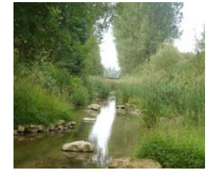
Exemple de travaux de renaturation du lit
