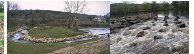
Aménagement du déversoir des moulins : bras de contournement, rampe d'enrochement
