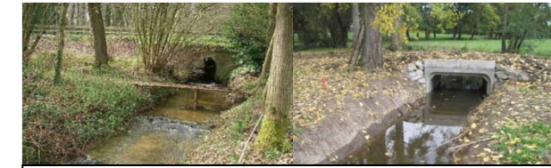
Amélioration du franchissement piscicole des ouvrages de franchissement : remplacement par un pont cadre OU succession de seuils à l'aval OU recharge granulométrique en aval
